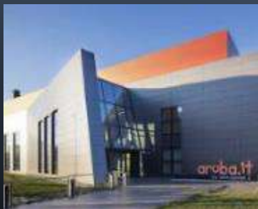
Campus Data Center IT 3 Ponte San Pietro (BG) 200.000 m 2 di Proprietà
