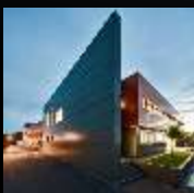
Data Center IT 1 e IT2 Arezzo 5.000 m 2 e 2.000 m 2 di Proprietà
